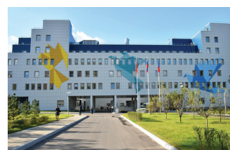
Перинатальный центр, г. Щелково
