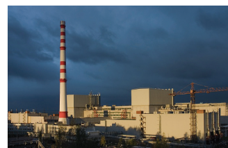
Ленинградская АЭС, г. Сосновый Бор
