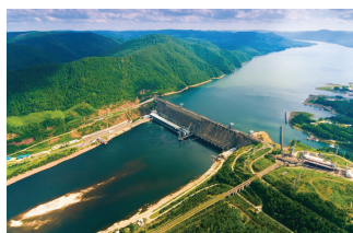
Красноярская ГЭС, г. Дивногорск
